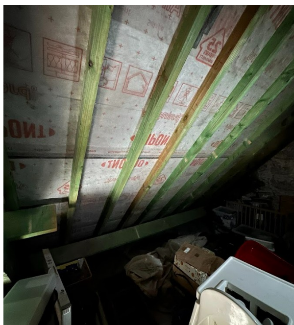
Figure 5 : Manquement du chevron
